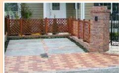
土間コンクリート+レンガ敷 レンガを使ってアクセントを
