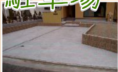
土間コンクリート スタンダードな駐車場
